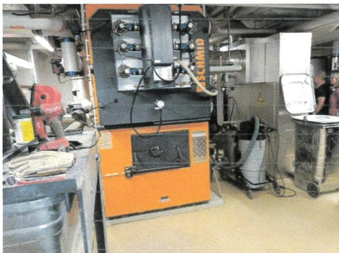
*Chaudière Schmid et en arrière-plan filtre à particule*
