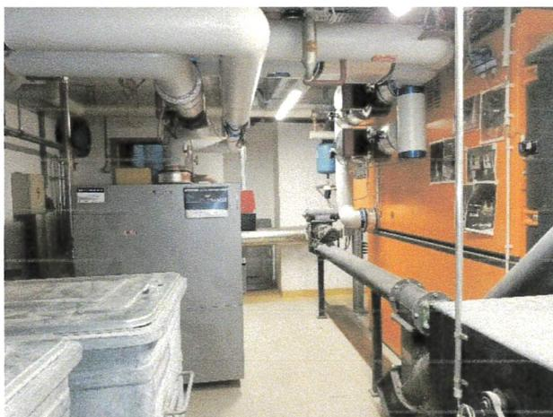
*En gris à gauche, la chaudière à gaz et à droite la chaudière Schmid à plaquettes*
