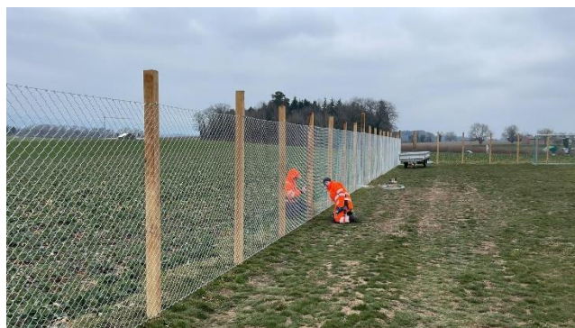
Pose d'une clôture autour du terrain de foot de Cottens
