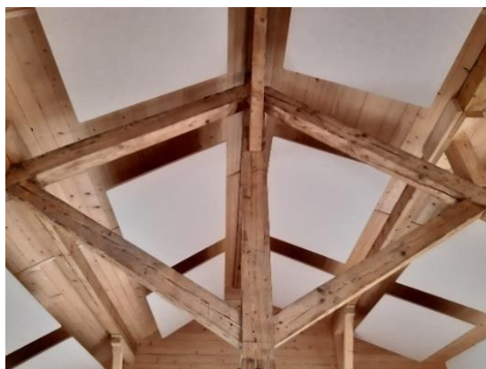
Ancien stand de tir de Pampigny
