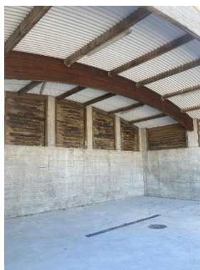
Création d'une place de lavage
