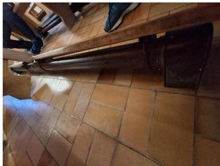
*Corps de chauffe sous banc*
